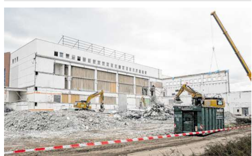
Bei der Höffner-Filiale werden Gebäudeteile komplett abgerissen. BILD: JUNGBLUTH
